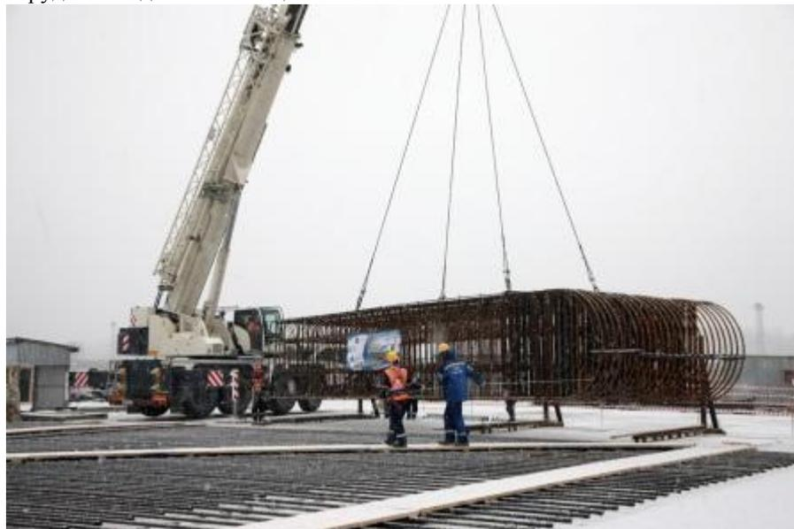
6 февраля 2018 года завершены последние приготовления к отправке на площадку сооружения энергоблока №1 Курской АЭС-2 первого крупногабаритного оборудования - устройства локализации расплава (УЛР) активной зоны. Изготовителем выступила машиностроительная компания АО "Энерготекс".
